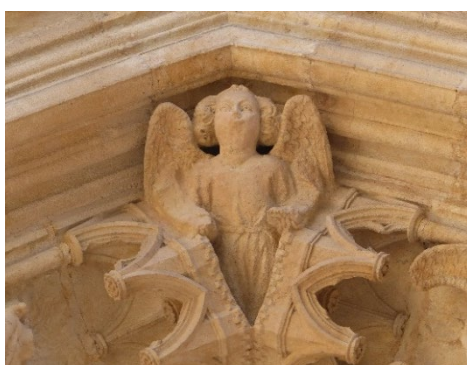
Portail central, au sommet des voûtures
