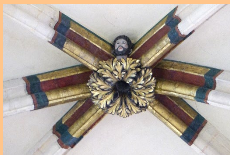
À 32.50 m du sol, visage dans une clé de voûte
